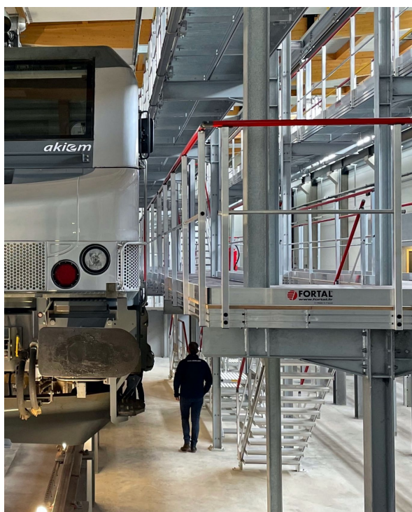
Treppe zum Zugang vom Boden der Grube
