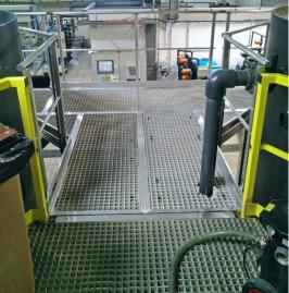
Laufstege aus stranggepresstem Rohaluminium 100 x 35 mm, die es dem Personal ermöglicht, sich sicher um die Silos zu bewegen. Sie fügen sich perfekt in die Umgebung ein und ergänzen ein bereits vorhandener Laufsteg.
