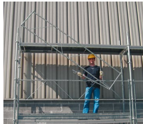
Déverrouillage du 2 e bras articulé
