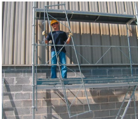
Déverrouillage et déploiement du 1 er bras articulé
