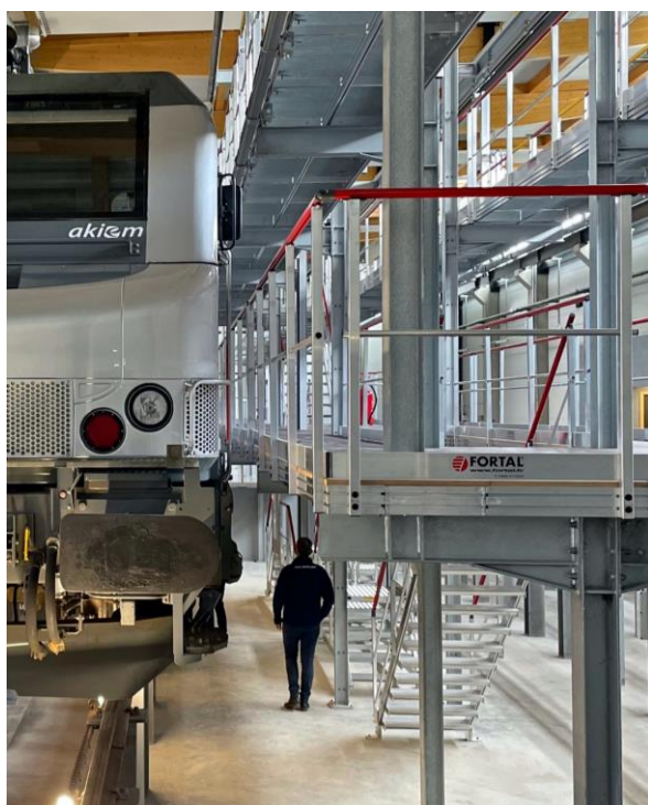
Escalier d'accès depuis le fond de la fosse
