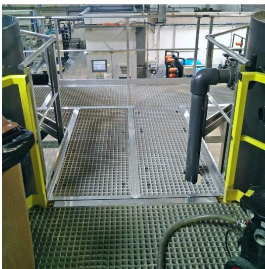
Plateforme en aluminium brut extrudé 100 x 35 mm permettant aux opérateurs de circuler autour des silos en toute sécurité. La plateforme s'intègre parfaitement à l'environnement d'accueil et vient compléter une plateforme déjà existante.
