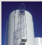
Crinoline avec changement de volée et sortie élargie sur silo de stockage
