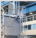
Crinoline sur plate-forme de montage
